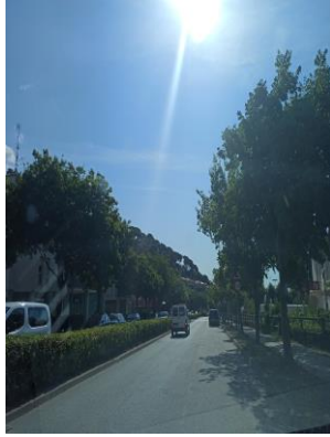
c. Via Cannetum (Marques en mal estat)
