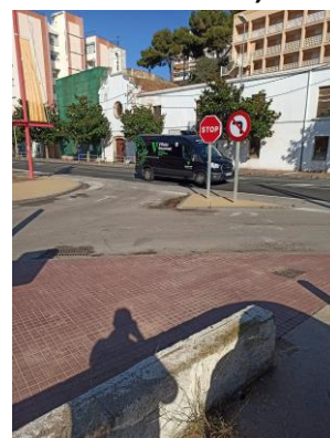
rotonda C.Drassanes (N-II) (LD i pictogrames en mal estat)
